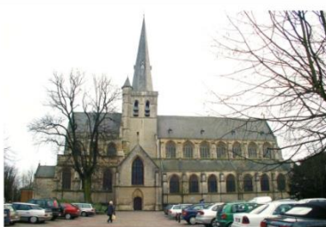
Kościół San Waldestrudis, Herentals
